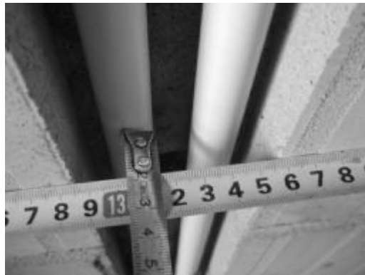
现场暗埋管线离墙面距离实测
