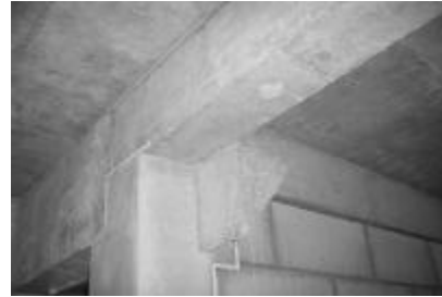
先扎构造柱再砌墙最后浇筑混凝土
