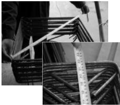
箍筋加工现场实测实量
