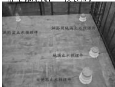
卫生间预埋套管弹线定位
