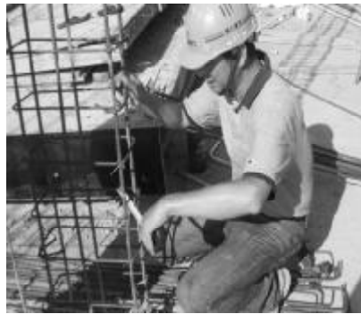
箍筋安装后尺寸复核
