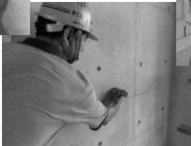
墙体砌筑过程中对开间、进深进行实测实量
