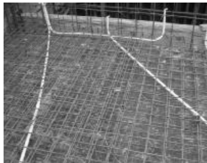
楼板转角处配置放射筋图
