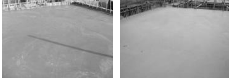
楼板混凝土浇筑效果实拍
