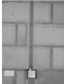
填充墙敷设管线实例
