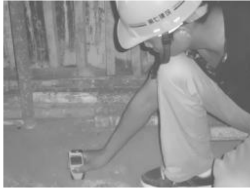
平台模板支设后测量净空高度
