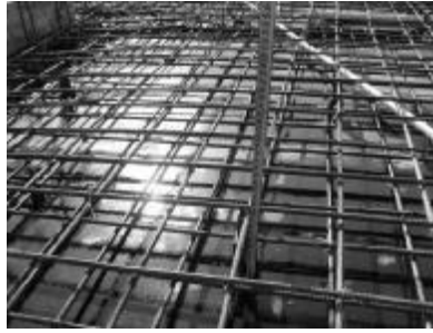
楼板钢筋保护层实测实量
