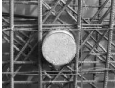
通过限位钢筋控制防水套管位置
