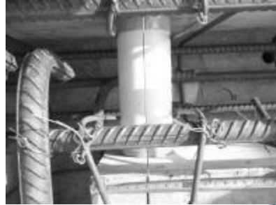
楼层给水管穿梁预埋套管
