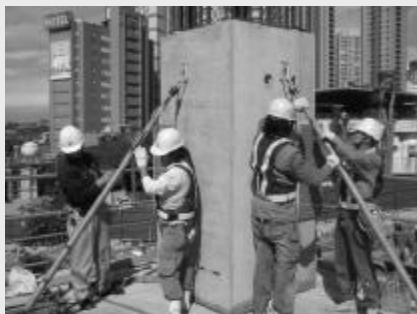
安装后斜撑固定
