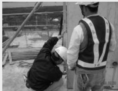
预制柱垂直度测量调整
