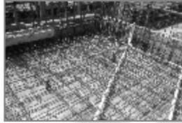
7. 楼板转角处配置钢筋网片
