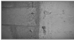
8.墙体不同材料交接处应设钢丝网片
