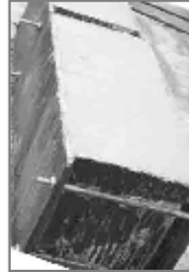
2.二结构施工中用定型钢模板预制砼块材
