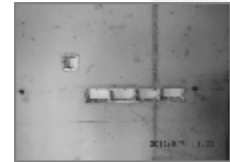
10. 结构墙板施工中安装线盒的控制。
