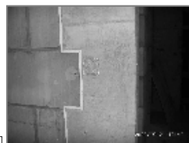
墙体构造柱实景图
